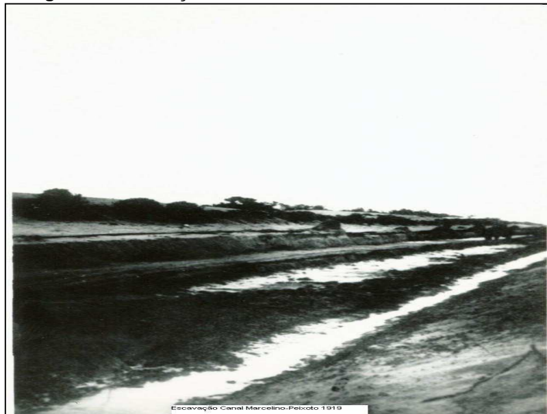
Figura 4 - Escavação do Canal Marcelino-Peixoto em 1919
